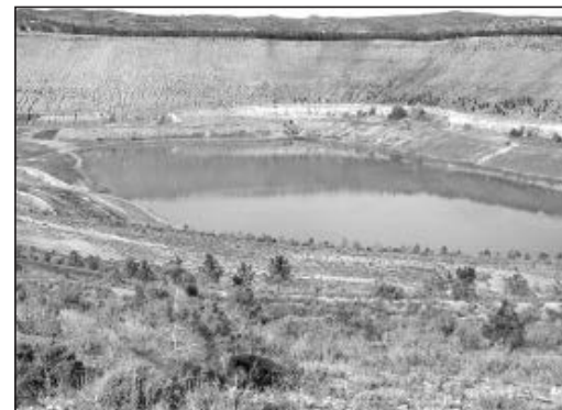
Balsa freática en el hueco de una enorme mina abandonada por ENDESA al norte de Estercuel.
